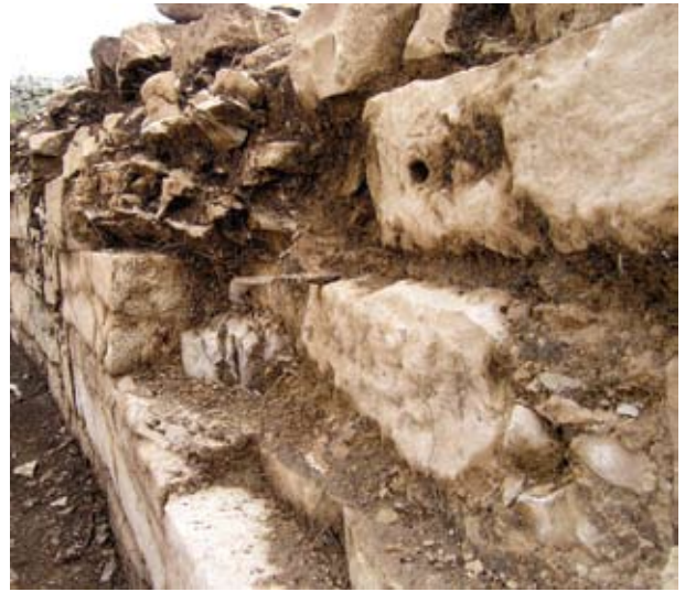
Sl. 44. Način pričvrščivanja kamenih blokova plašta arene
