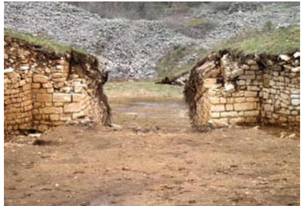
Sl. 5. Pročelje južnog ulaza
