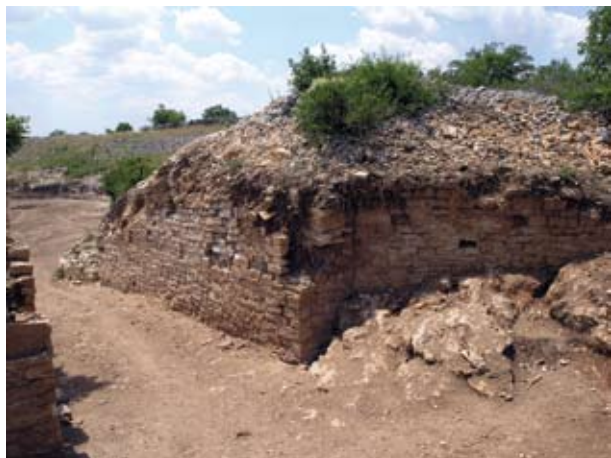
Sl. 38. Sjeverni ulaz, desna strana
