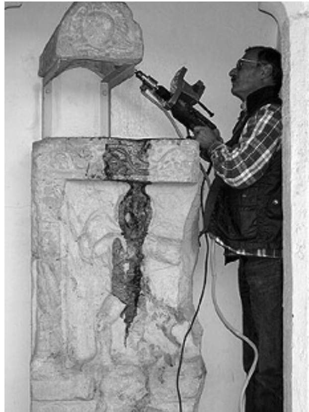
ABB. 2 BEPROBUNG EINES DENKMALS MIT EINEM WASSERGEKÜHLTEN DIAMANTBOHRER.
